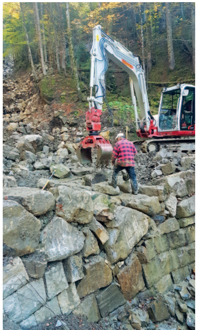
Erstellen von Furten am Kistenweg und am Fallhörnlweg
