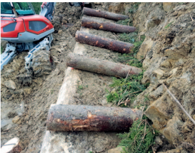
Rutsch Witenmattegg – Einbau Holzkasten und Wiederinstandstellung des Strassenbanketts
