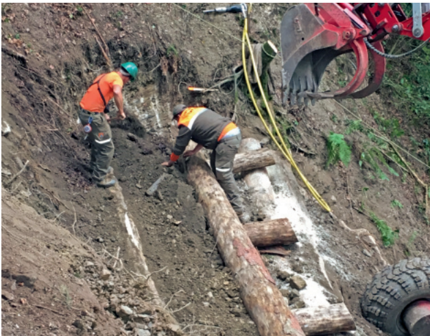
Kastenwerk an der Buchwaldstrasse
