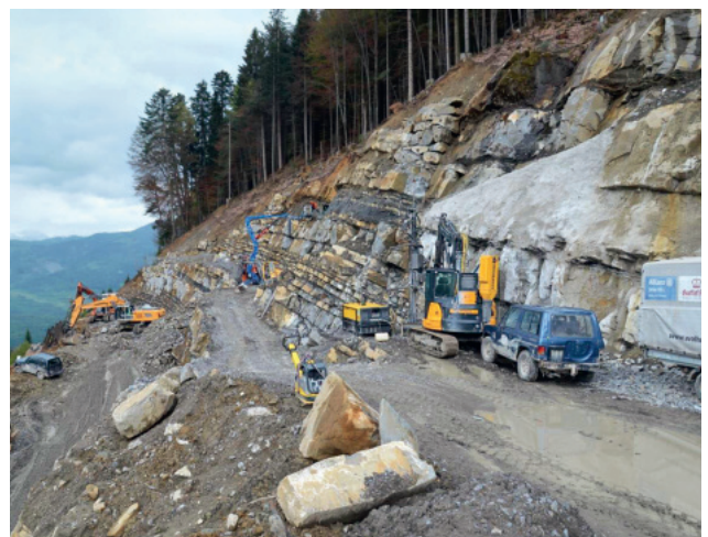
Abbau Guber West und Hangsicherung
