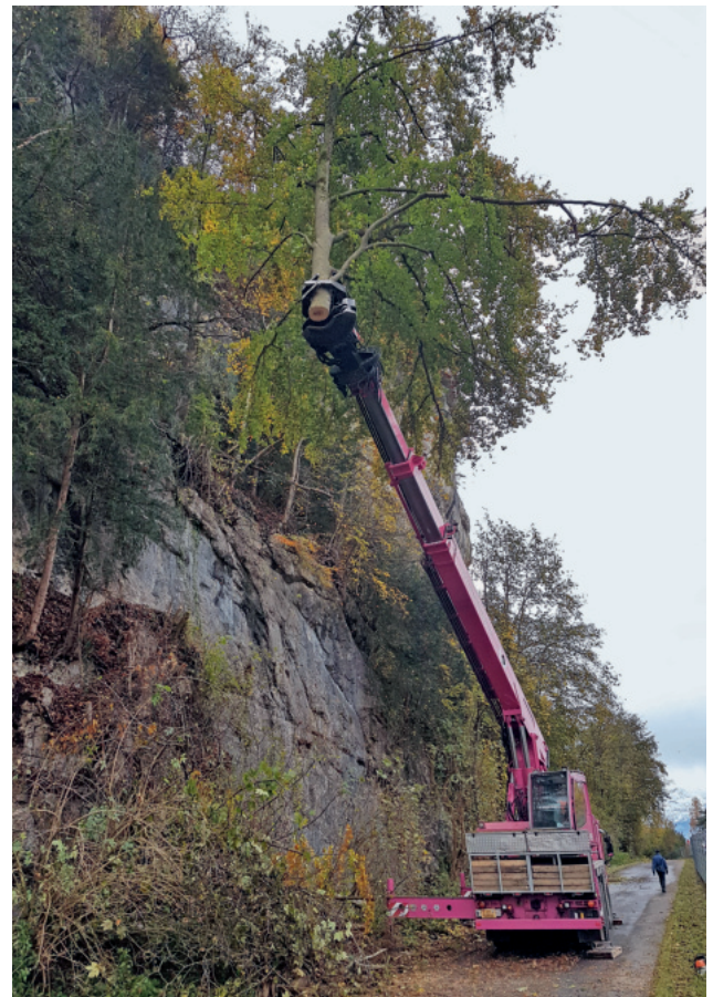
Holzerei beim Wartdossen
