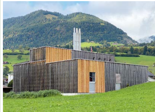
Gesamtansicht von Nordost
