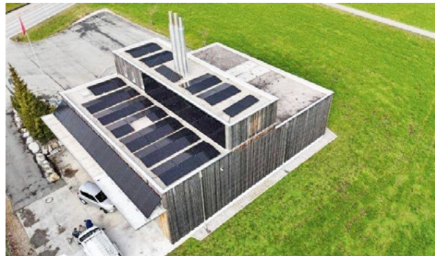
Photovoltaikanlage auf dem Dach des Wärmeverbundes
