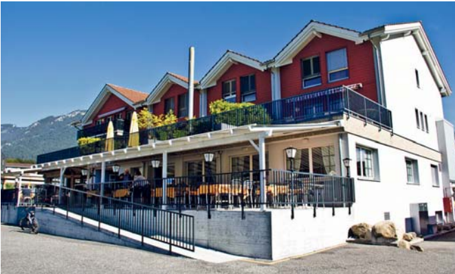
Restaurant Adler ab 1997 bzw. mit erweiterter Terrasse ab 2011
