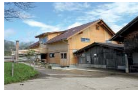
Der im Mai 2015 fertiggestellte Alpstall.
