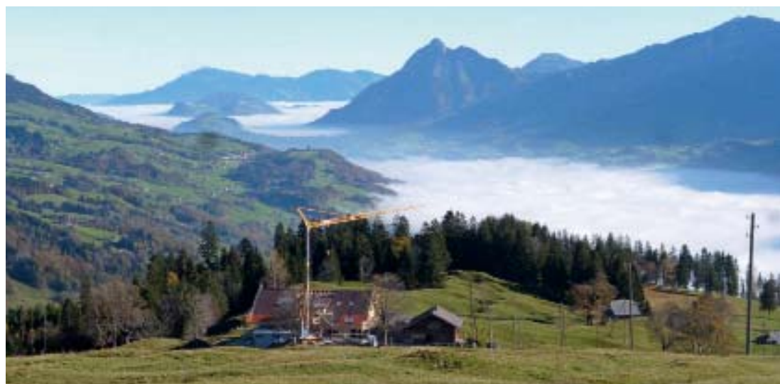
Ausblick von der Alp Iwi. In der Bildmitte der sich im Bau befindliche Alpstall.
