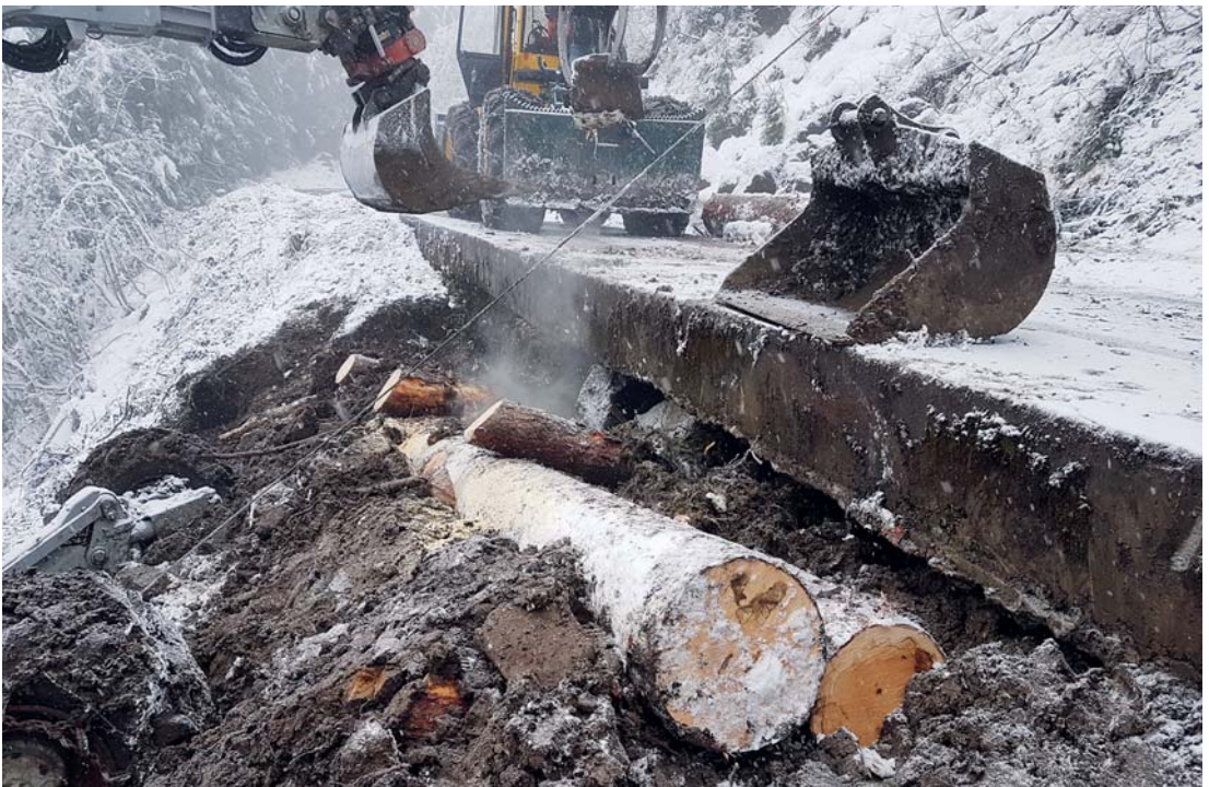
Verbauung Schneeloch: Fundament Strasse
