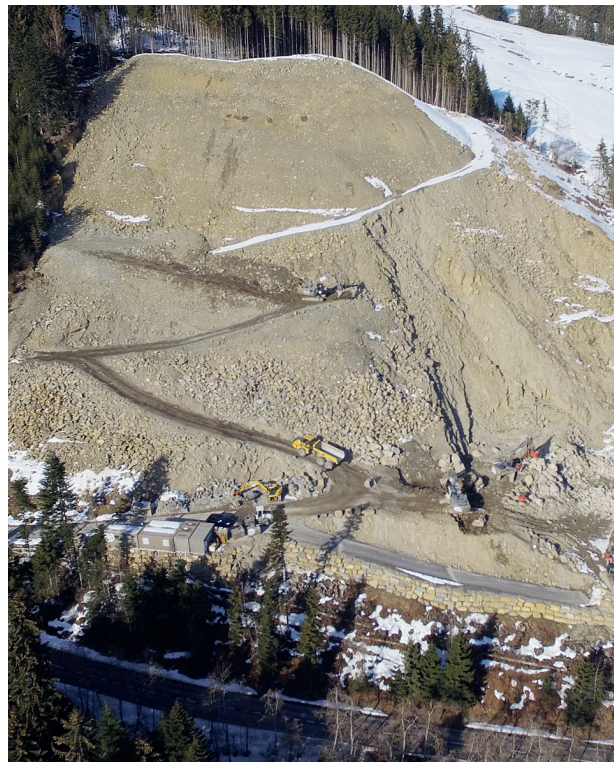
Wuhrstein-Abbau im Rischi, Situation am 19. Februar 2019
