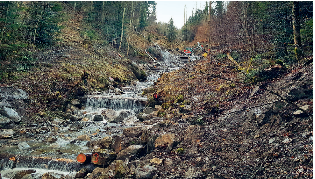
Fertig ausgeführter Bachabschnitt mit bestehenden und neuen Verbauungselementen
