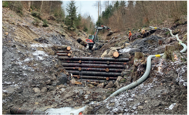
Ersatz der Schwelle durch eine doppelwandige Holzkastensperre
